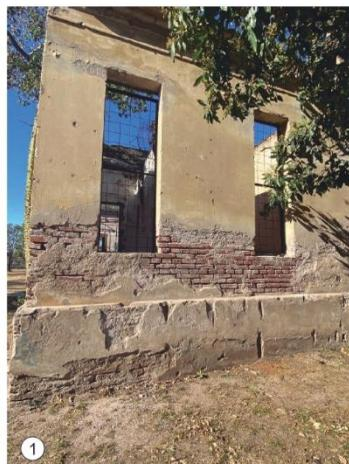
1 Erosión y desprendimiento de juntas ent mampuestos, y material de acabado (revoques pintura) en paredes exteriores.
