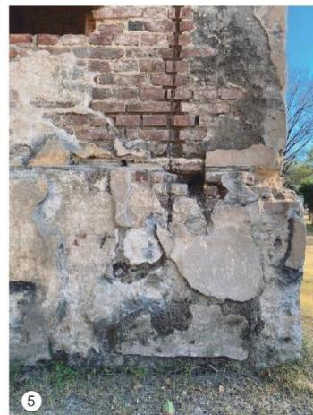
5 Erosión y desprendimiento en ladrillos y zócalo de pared.
